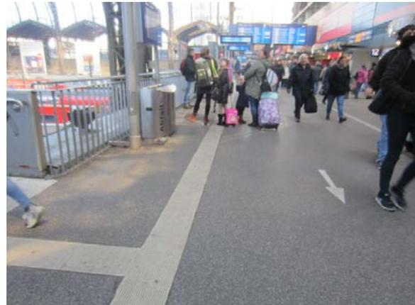
Der Blindenleitstreifen entlang des Südstegs ist schlecht ausgeführt (profilarme Kaltplastik), für Blinde nicht nutzbar. Der Leitstreifen müsste zudem mehr in der Mitte verlaufen.
