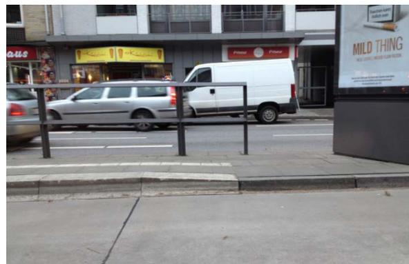
Abb. 9: Positivbeispiel: Bauausführung mit Übergangsstein, Hochbahn 2015.
