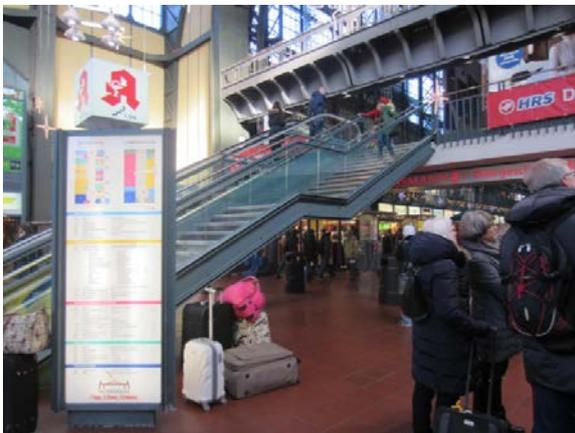
Der Treppenaufgang ist nicht gekennzeichnet. Für blinde und sehbehinderte Menschen ist die Gefahr groß, dass sie die Treppe unterlaufen und sich stoßen.
